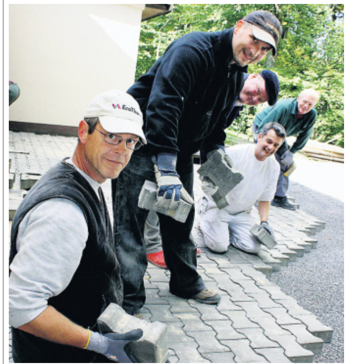
Packen's an: Ralf Todt (von links), Jörg Bechtel, Manfred Schmidt, Peter Kleine und Dieter Lechtenfeld verlegen die ersten Pflastersteine für den neuen Vorplatz. FOTO: A. MARIC
