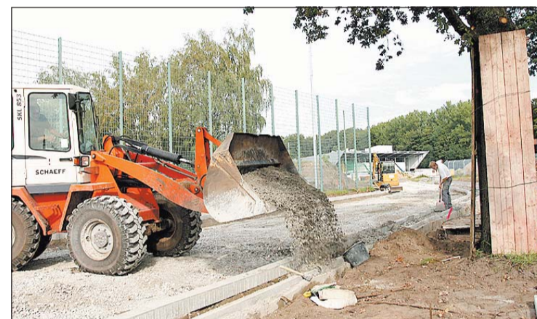
Die Straße zur Sporthalle am Stadtpark nimmt ebenso deutlich sichtbare Konturen an wie das Bauwerk selbst. Die Kantensteine für Fahrbahn und Radweg sind schon gesetzt. Fotos: Oliver Horst
